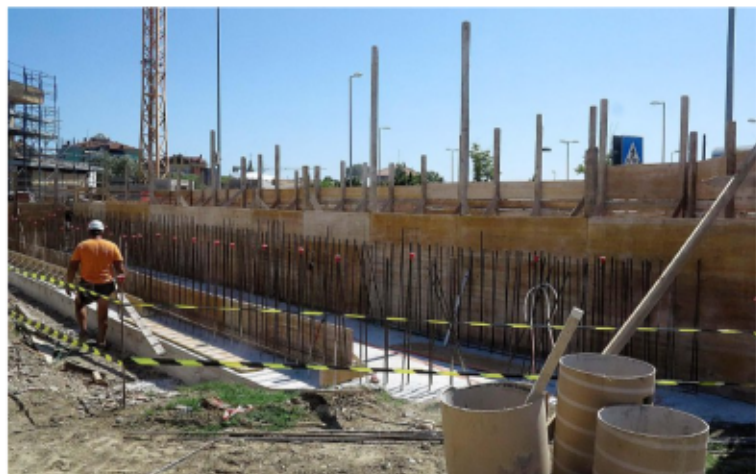
Un operaio al lavoro in un cantiere FOTO DI ARCHIVIO
